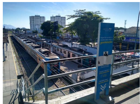
Figura 6-27 – Estação Santa Cruz – 29/11/2020
